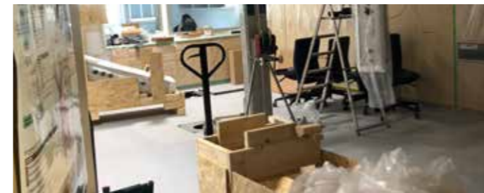
Nur jeweils sechs Wochen lagen zwischen der Stilllegung der bisherigen Herzkatheterlabore und der Inbetriebnahme der neuen Anlagen.
